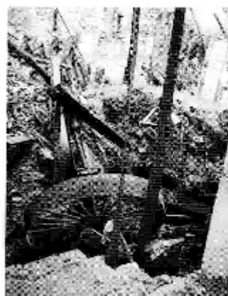
Restos de la central eléctrica.
